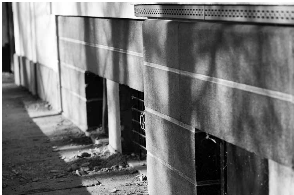
Sérülékeny modernizmus. A Friedmann-ház eredeti műkő lábazata, fölötté a fal síkjából kiugró hőszigetelő réteg a műanyag nemes vakolattal, 2022 elején © Zuh Deodáth
