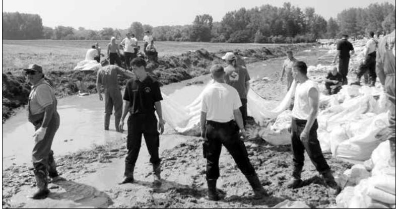
Árvízi védekezés Győrújfalunál 2013-ban
